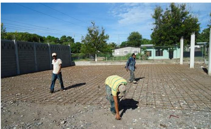
galera de 15 x 35 mts. para extender los bloques recién hechos. La estamos fabricando. La foto muestra las columnas ya terminadas y el piso enrejado con varillas de hierro. Estamos listos para fundir la placa de concreto en los próximos días. Cuando fragüe el concreto podremos traer las máquinas del antiguo “**INCATEC**” para seguir fabricando los bloques en este nuevo lugar. El techo lo pondremos más adelante, cuando recuperemos una parte de la inversión.
